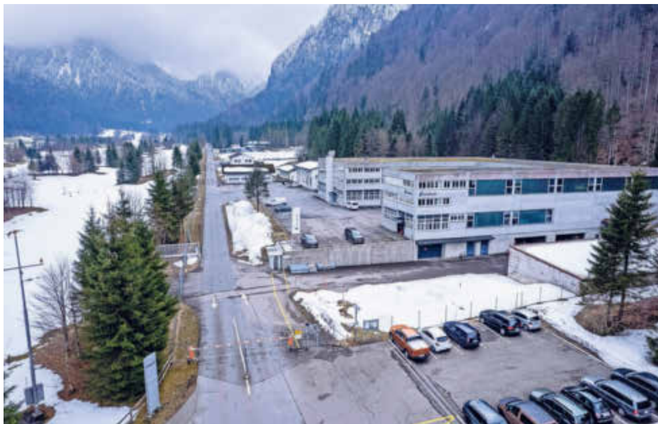
Die deutsche Rheinmetall AG plant einen Ausbau der Anlage in Unteriberg/Studen.
